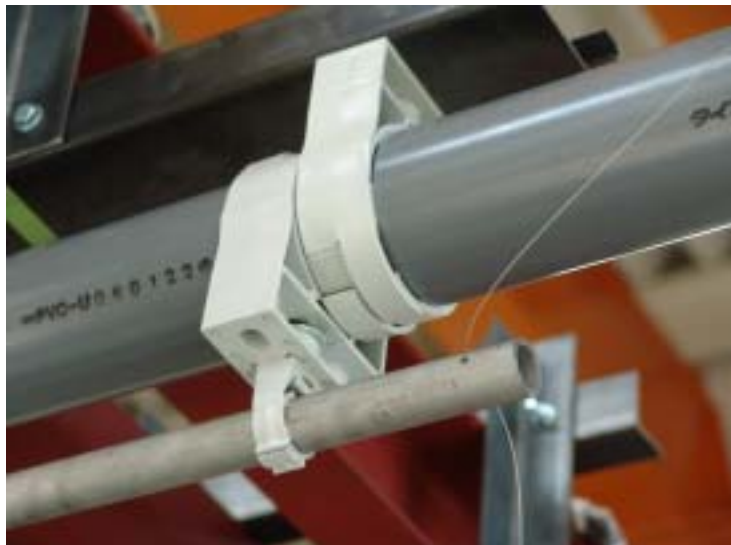
既設配管に、新規電線管を追加敷設した状態 太い配管が既設配管 VU 管 75、下の細い配管が電線管呼び径 20(外径 27.2mm)重量 7.1kg
